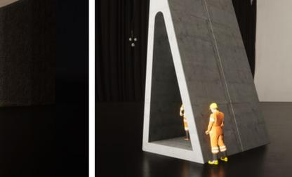
Detalle de piezas prefabricadas para muro de contención con pasillo interno.
